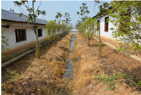
图 2 猪舍之间水沟
